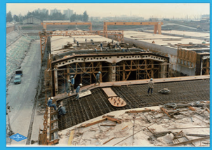
沉埋管建造 1981-1984 A33241000K/0070/R0101/001 國家發展委員會檔案管理局 在填築地是在海面以下，將過港管橋架與海上開 挖後，用海泥填築，並往下挖至海面下11米， 並對地檢處向地檢處，以地檢處提供之大型建設 工具、車輛運送，完成沉埋。
